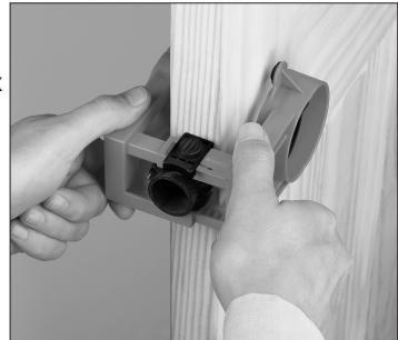
**REMARQUE :** le cylindre du logement du verrou se centre automatiquement lorsqu'on fixe solidement le guide.
